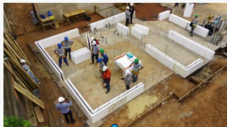
Obra de montagem de paredes de concreto ARXX
