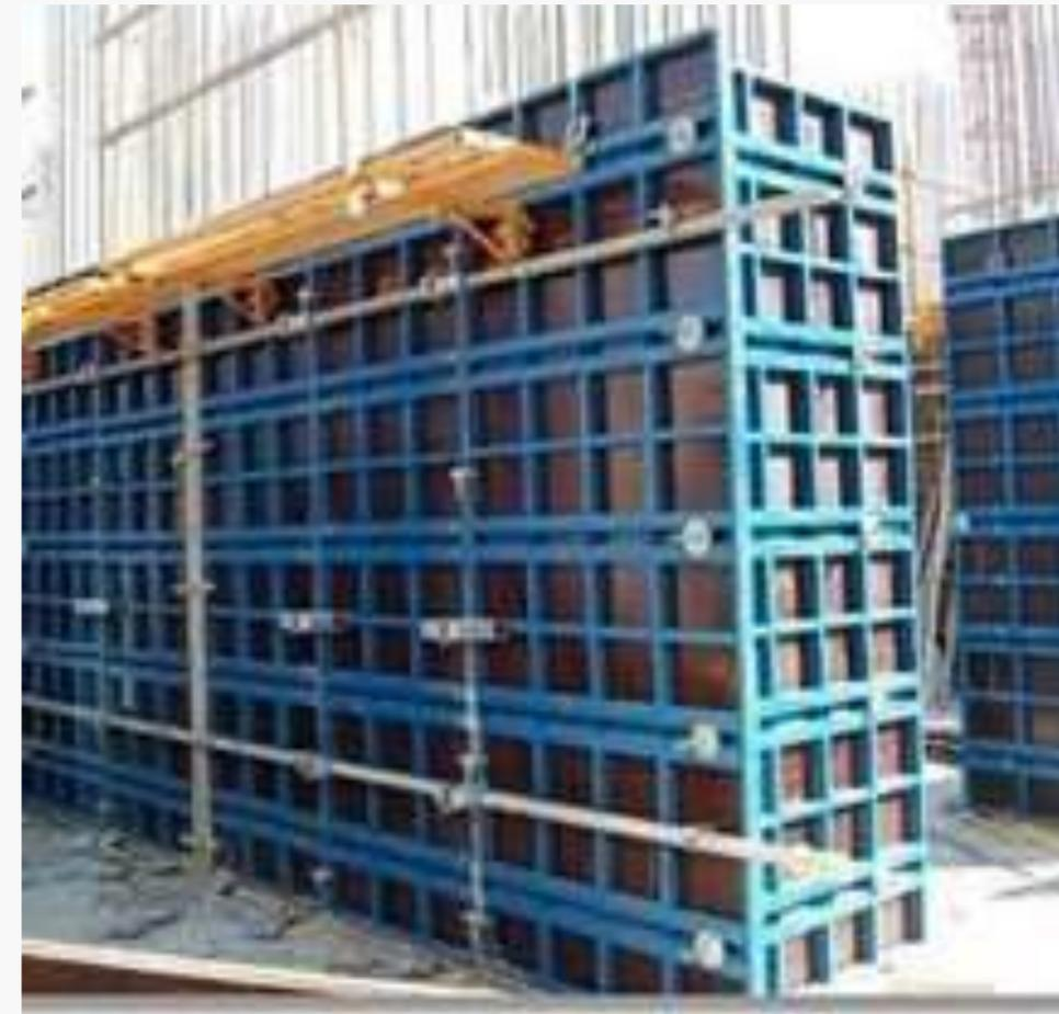
Fôrmas plásticas - Como o nome sugere, as fôrmas plásticas são feitas com resina plástica, mas também contam com fases metálicas para enrijecer o conjunto. As faces de plástico são as que ficam em contato com o concreto. O sistema de formas plásticas é industrializado e permite um alto número de repetições de uso, sendo muito indicado para obras de conjuntos habitacionais ou projetos dessa escala.
