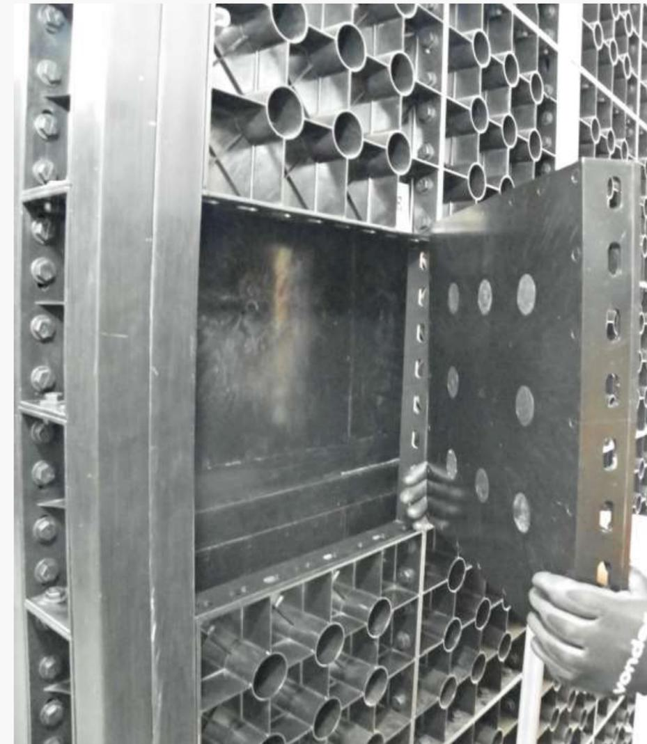
Cada elemento estrutural a ser concretado recebe o sistema de fôrmas dividido por painéis, estes separados e anexados facilmente na obra pelos formistas. O sistema é caracterizado como “modular”, pois utiliza módulos plásticos de várias dimensões para a fabricação dos painéis que são anexados entre si com travas especiais, garantindo resistência à peça, que passa a ser um elemento único, diferentemente das alvenarias.
