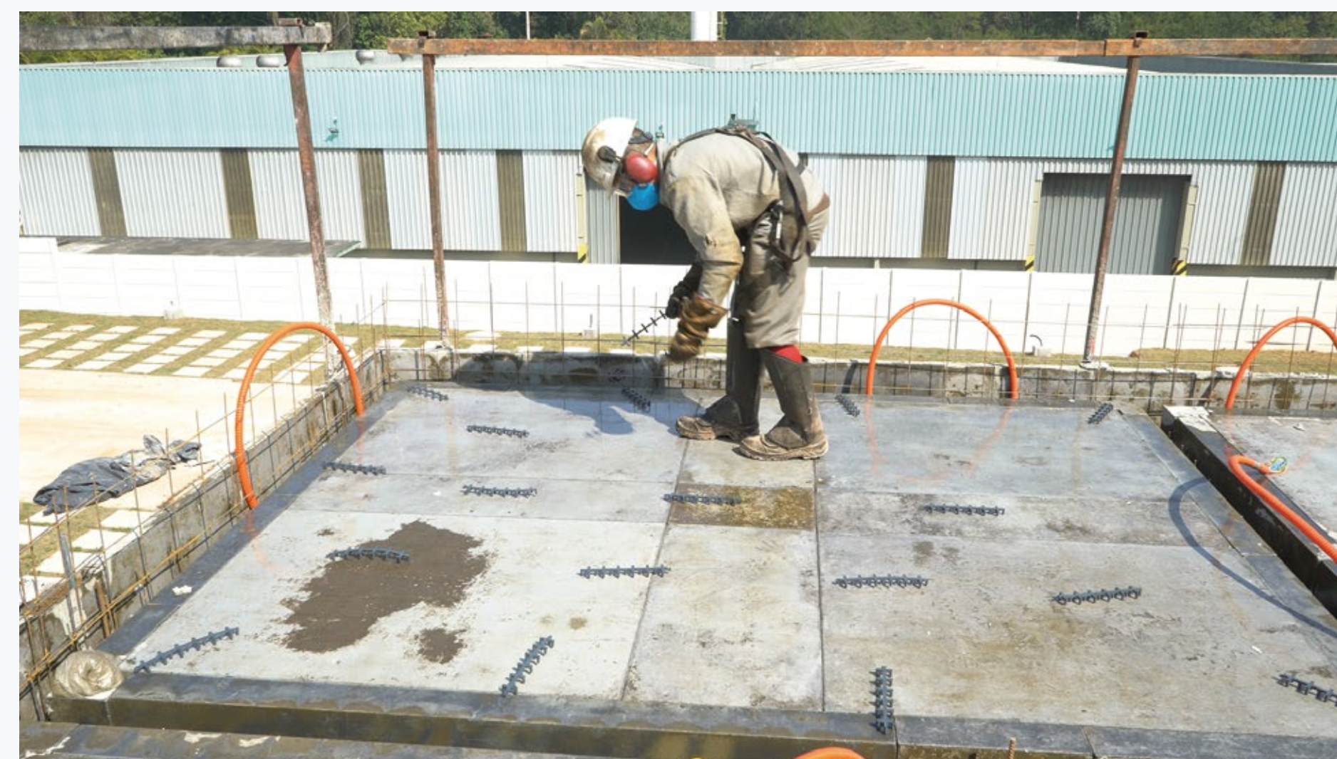
Instalação dos espaçadores
