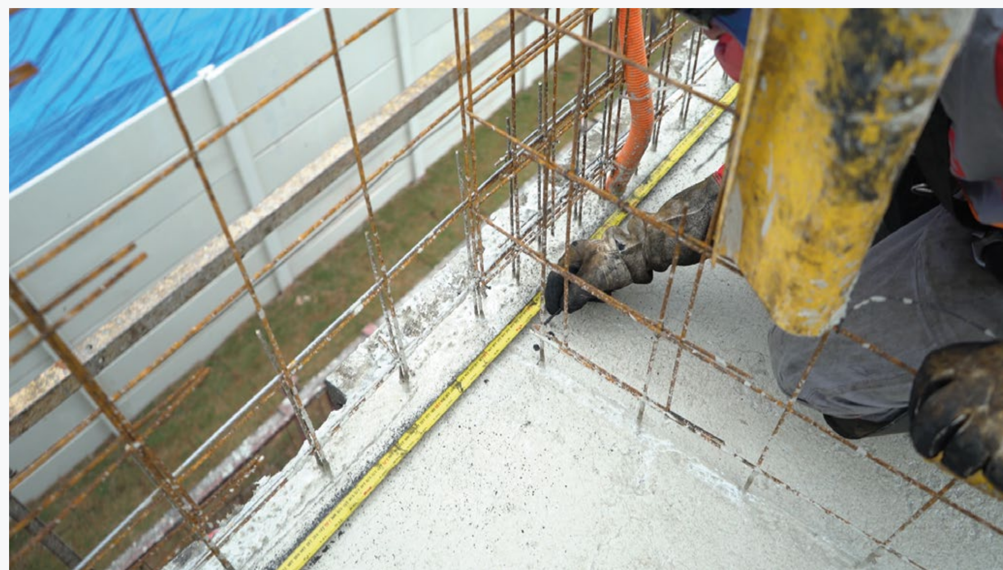
Marcação dos eixos no piso
