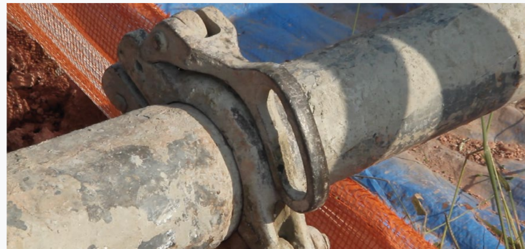
Fixação das conexões com braçadeira
