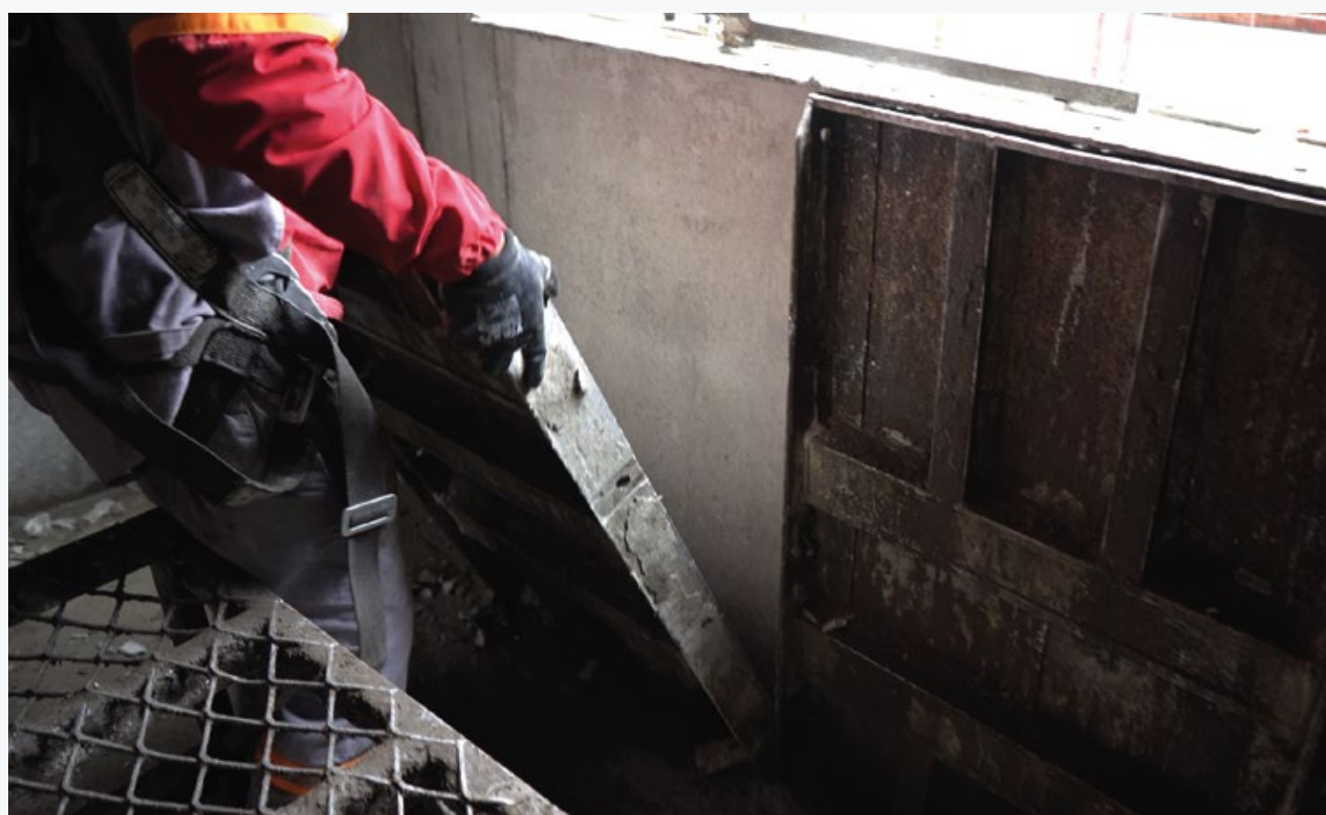
Momento da desforma da parede
