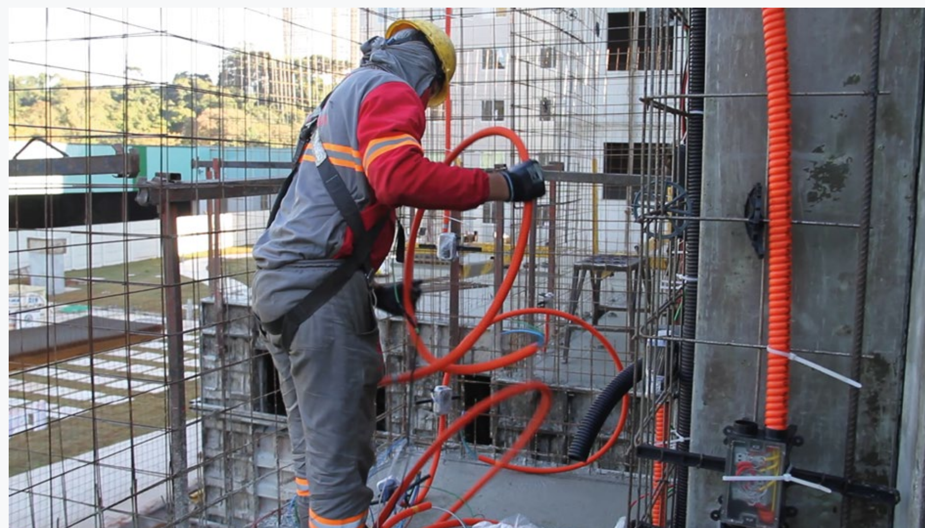
Instalação das tubulações embutidas
