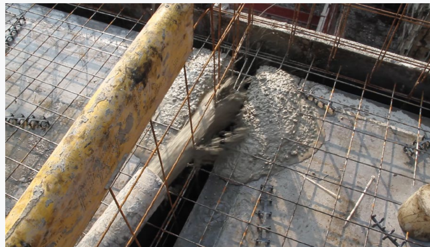
Lançamento do concreto na laje
