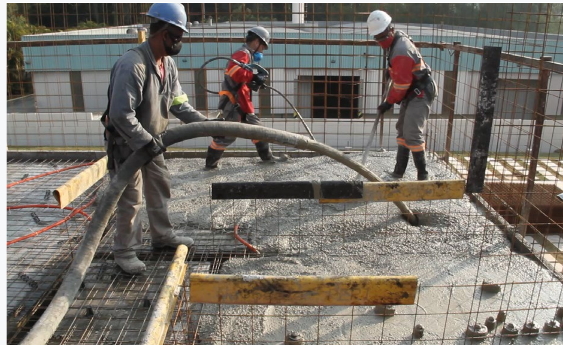
Lançamento, vibração e espalhe do concreto acontecem concomitantes
