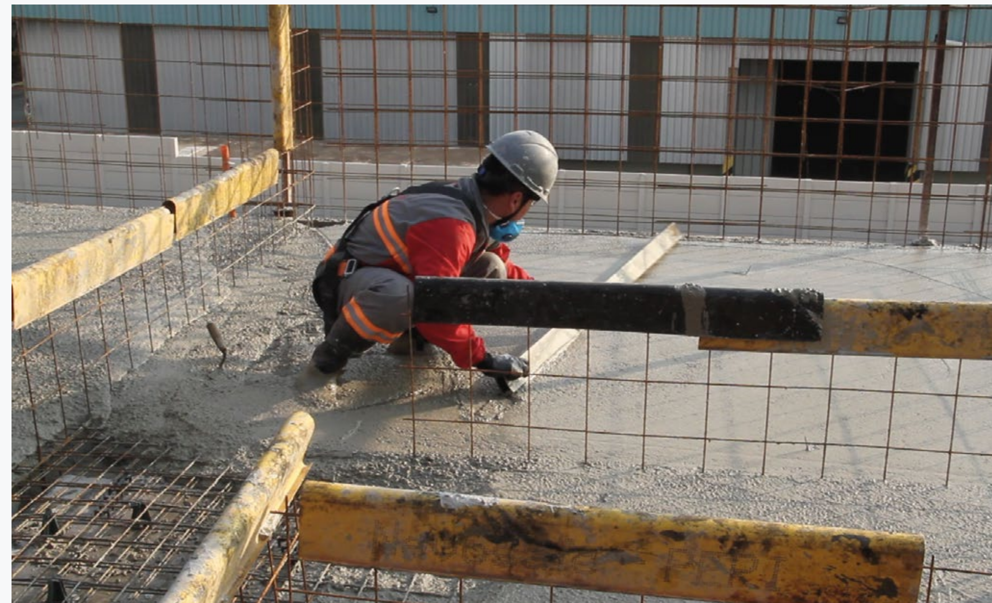
Sarrafeando a laje
