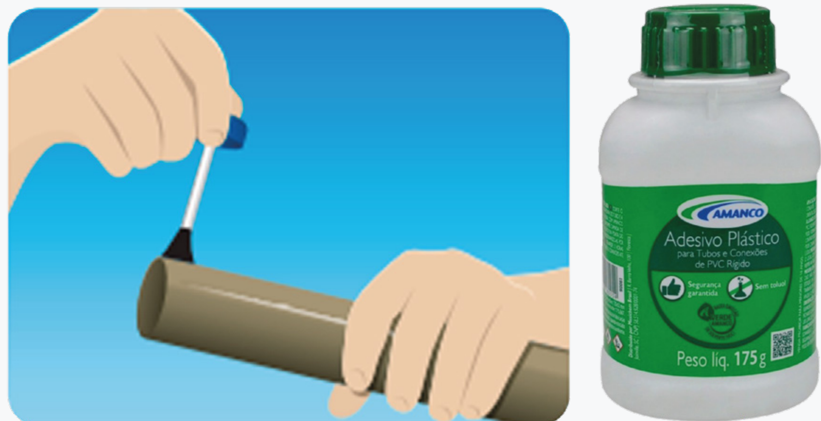
Figura 17: Aplicação do Adesivo Plástico PVC Amanco
