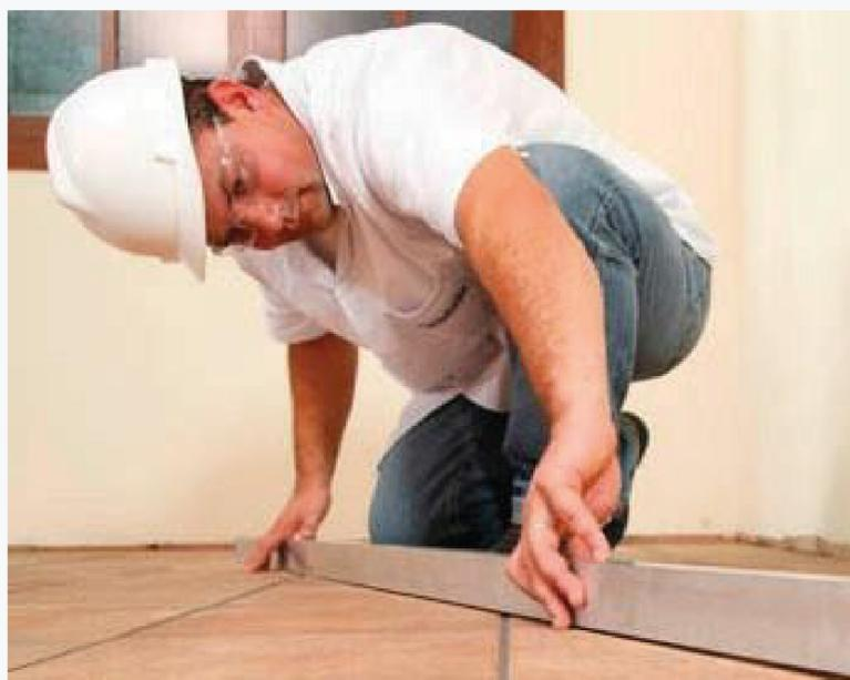
Figura 11: Inspeção de planicidade do piso de base
