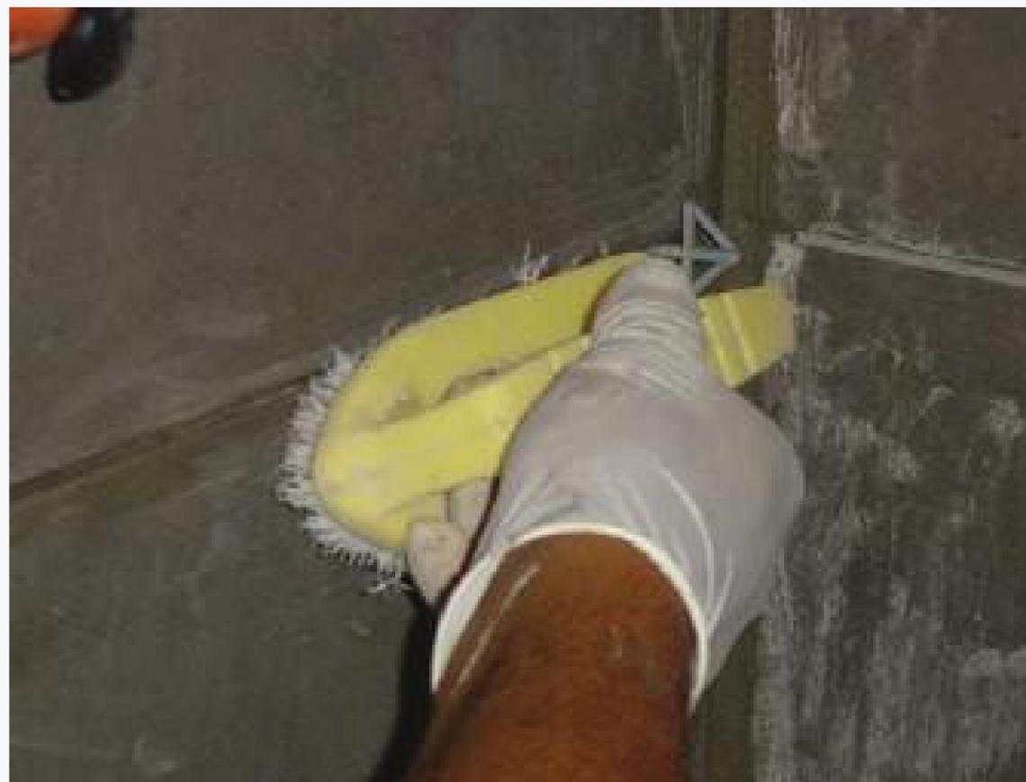
*Figura 23: Limpeza das juntas com auxílio de escova ou broxa*
