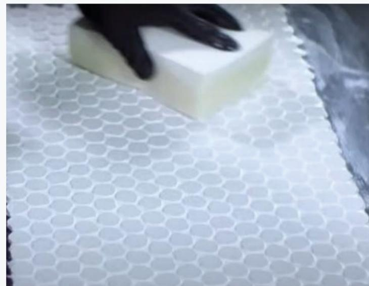
*Figura 28: Remoção dos rejuntes com movimentos circulares*
