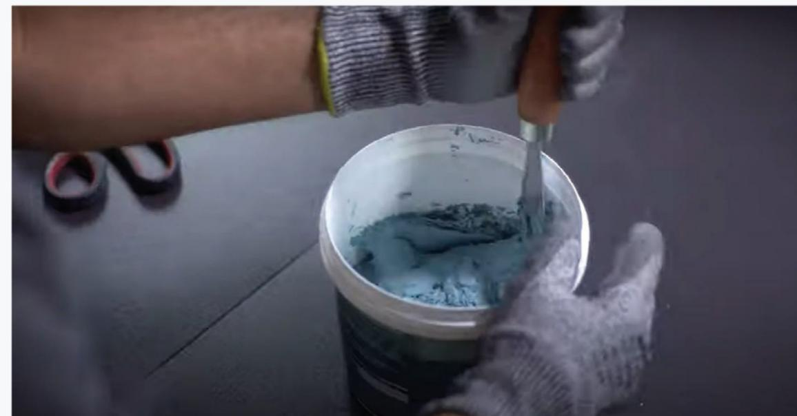
Figura 25: Mistura e homogeneização do rejunte
