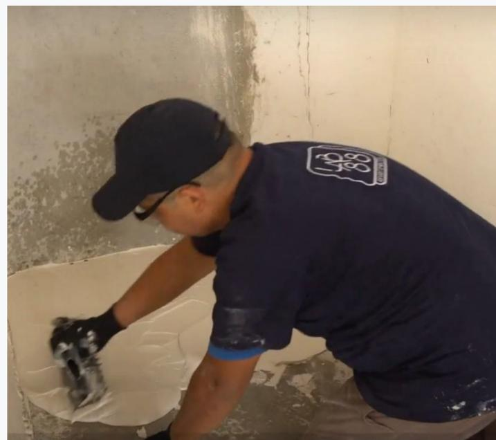
Figura 19: Aplicação da argamassa colante na base de assentamento
