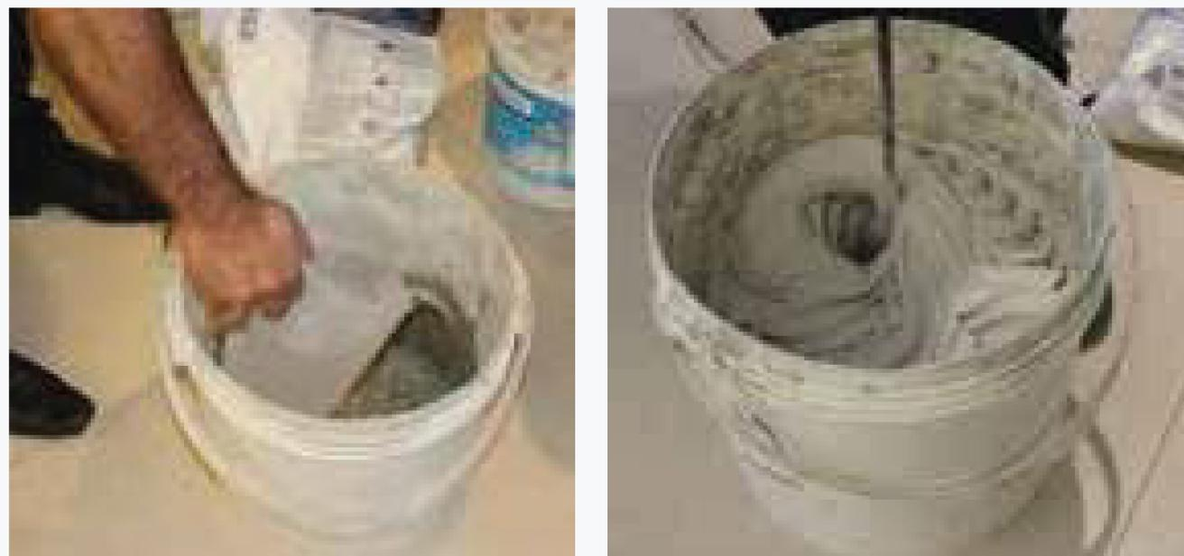
*Figura 13: Preparo da argamassa colante – adição da água e misturando com haste helicoidal*
