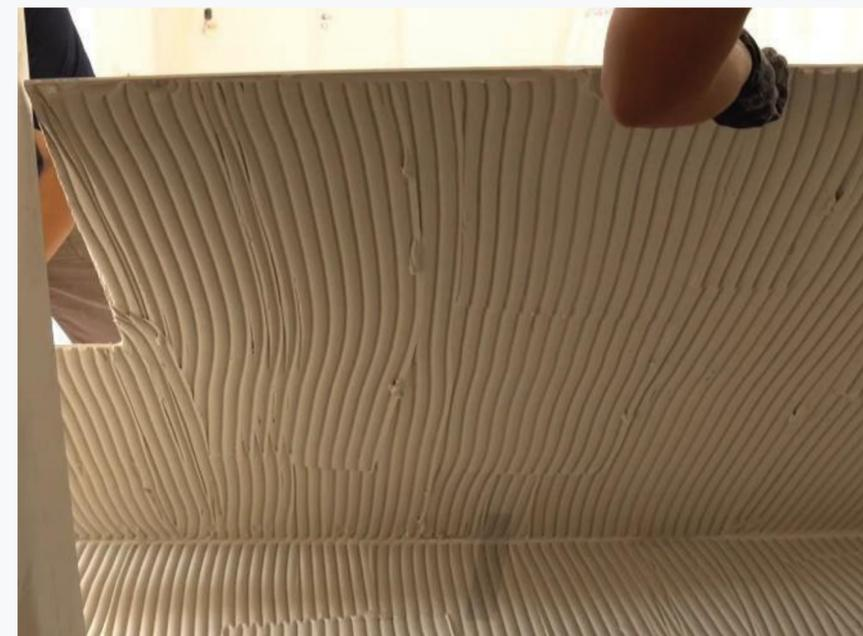
Figura 21: Descendo a peça sobre a base para execução da colagem
