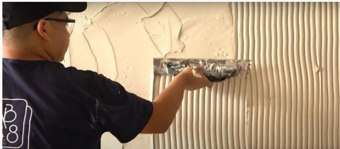
Figura 17: Formação dos cordões na argamassa colante
