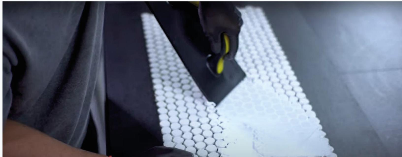
*Figura 26: Rejunte aplicado com o auxílio de uma desempenadeira*
