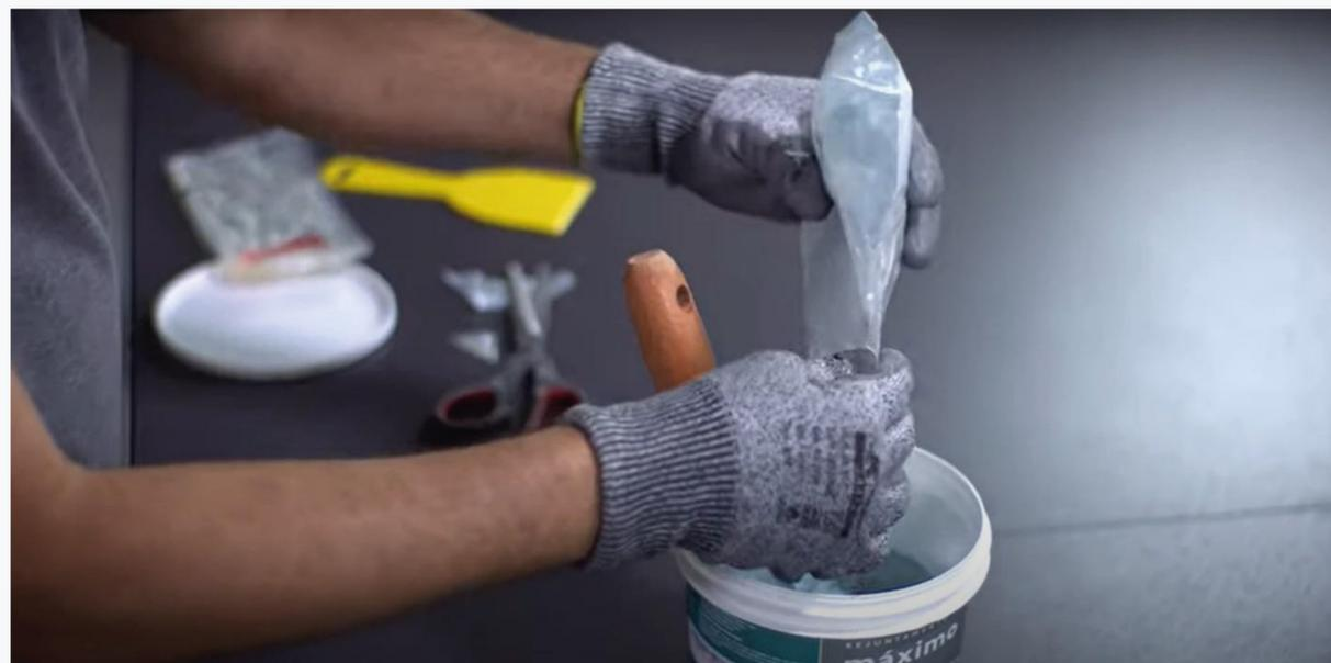
Figura 24: Mistura dos componentes quando necessário
