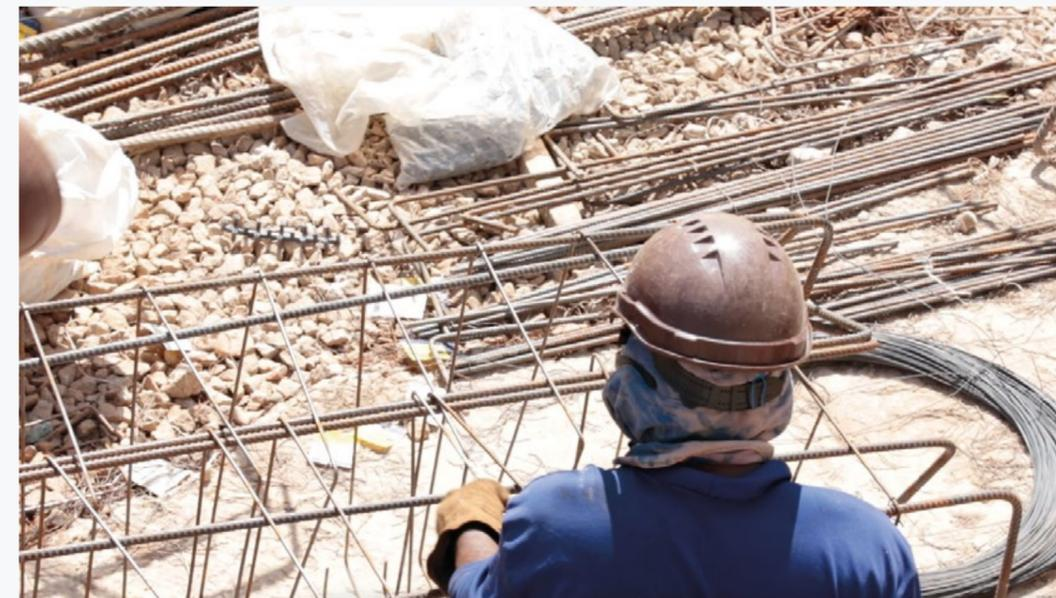
Armador montando as peças com aço cortado e dobrado
